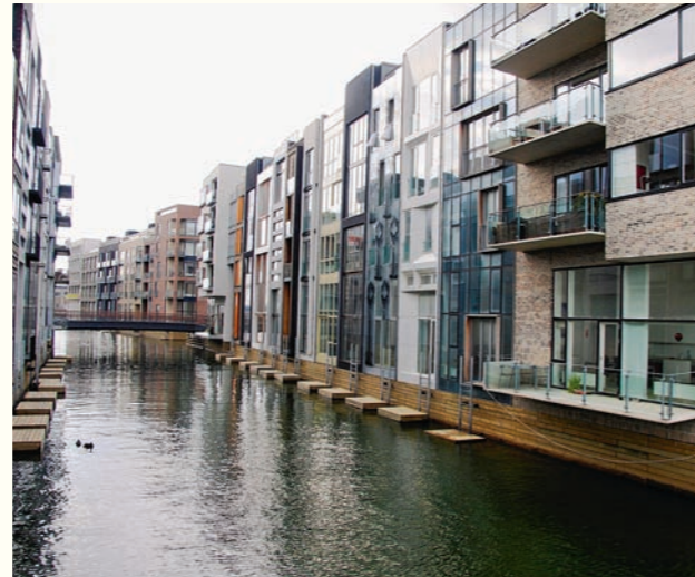
Fig. 246 Sluseholmen i Københavns Sydhavn, opført 2003 med Sjoerd Soeters som hovedarkitekt.
