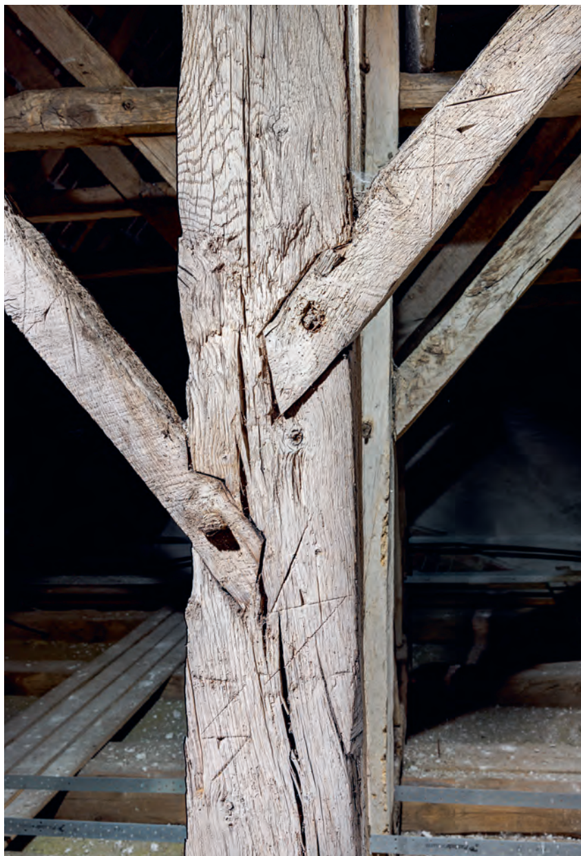
Fig. 28. Tommersamlinger og -mærker på 7. kongestolpe og skråstivere fra vest i langhuset tagværk (s. 3938). Foto Arnold Mikkelsen 2023. – Timber joints and carpenter's marks on the 7th kingpost and struts from the western end of the roofing of the nave church.
