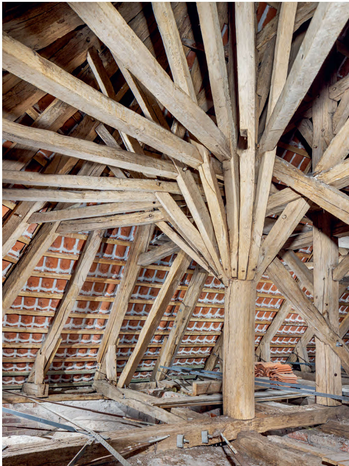
Fig. 29. Korets sengotiske tagværk set mod sydvest (s. 3938). Foto Arnold Mikkelsen 2023. – The Late Gothic roofing of the chancel looking south west.
