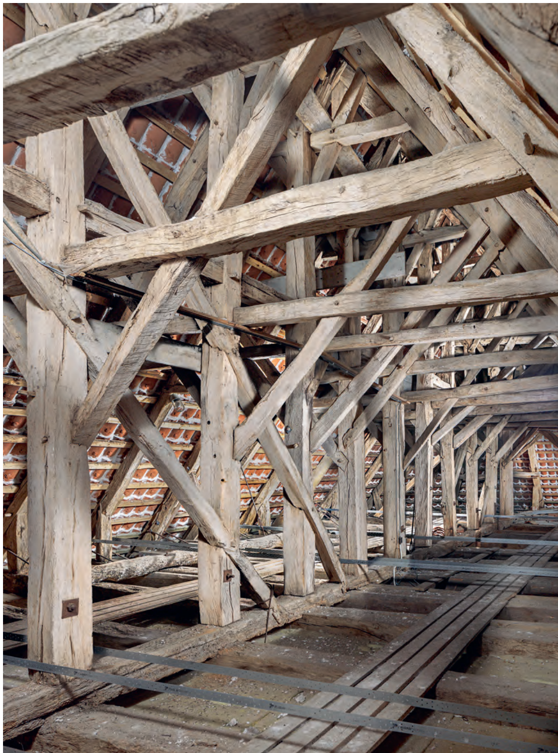
Fig. 26-27. Langhusets sengotiske tagværk fra 1440'erne (s. 3938). 26. Set mod nordøst. 27. Øverste del set mod øst. Foto Arnold Mikkelsen 2023. – The Late Gothic roofing from the 1440th of the nave church. 26. Looking north east. 27. The topmost part looking east.
