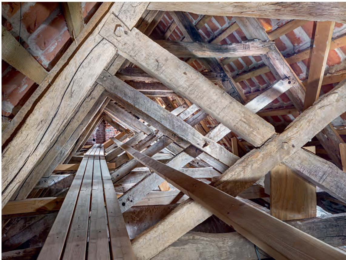
Fig. 45. Korets tagværk, oversigt, set mod øst (s. 6028). Foto Arnold Mikkelsen 2020. – Roofing of the chancel, general view, looking east.
