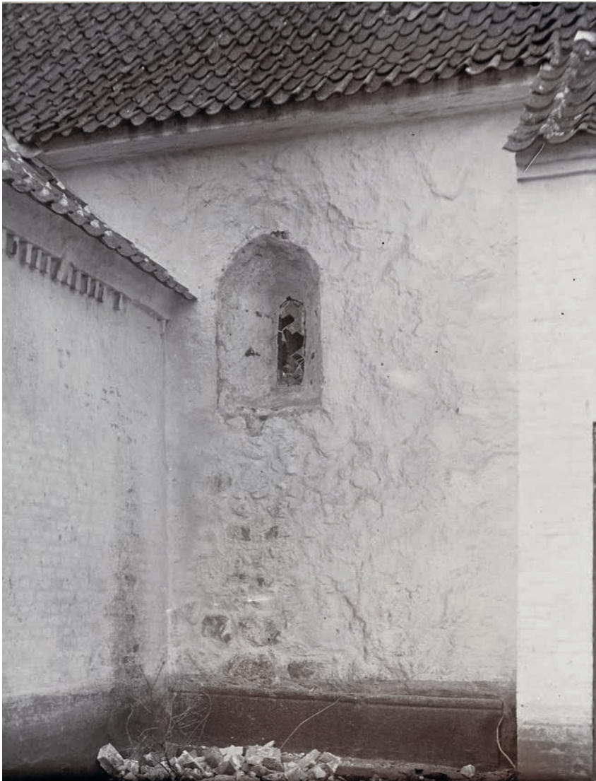
Fig. 82. Romansk vindue i †skibets nordmur (s. 2764). Bemærk *vinduesrammen med blyindfatning og glas i lysningen (s. 2776). Foto C. M. Smidt 1905. I NM. – Romanesque window in the north wall of the †nave. Note the *window frame with leading in the opening.
