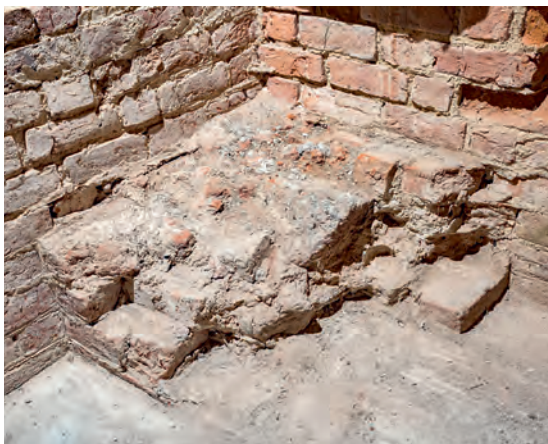
Fig. 22. Hvælpille i søndre kapels tagrums sydvestre hjørne (s. 5429). Foto Arnold Mikkelsen 2019. – Arch column in the south-west corner of loft of the south chapel.
