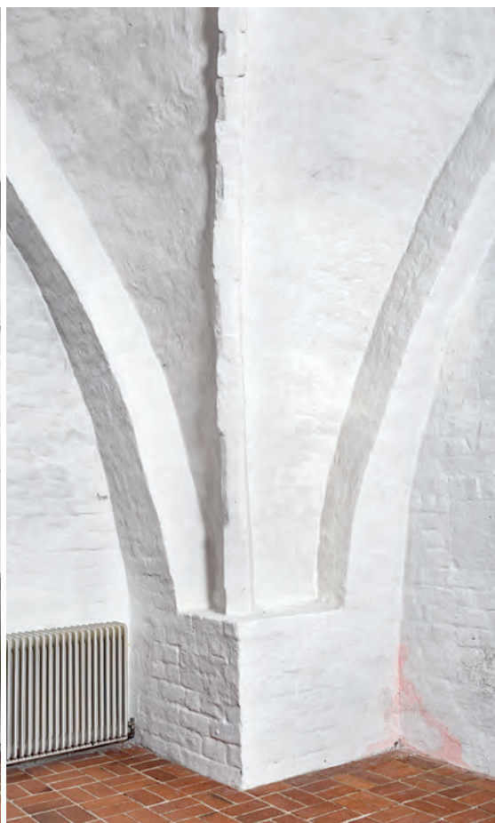
Fig. 23–24. Søndre kapel. 23. Arkade og nordøstre hvælpille (s. 5429). 24. Sydøstre hvælpille (s. 5429). Foto Arnold Mikkelsen 2019. – The south chapel. 23. Arcade and north-eastern vaulting pillar. 24. The south-eastern vaulting pillar.
