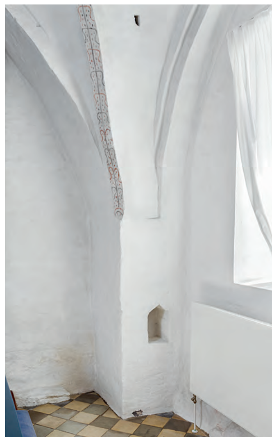
Fig. 21. Korets sydøstre hvælvpille (s. 4595) med niche. Foto Arnold Mikkelsen 2017. –Southeastern vault pillar of chancel with niche.
