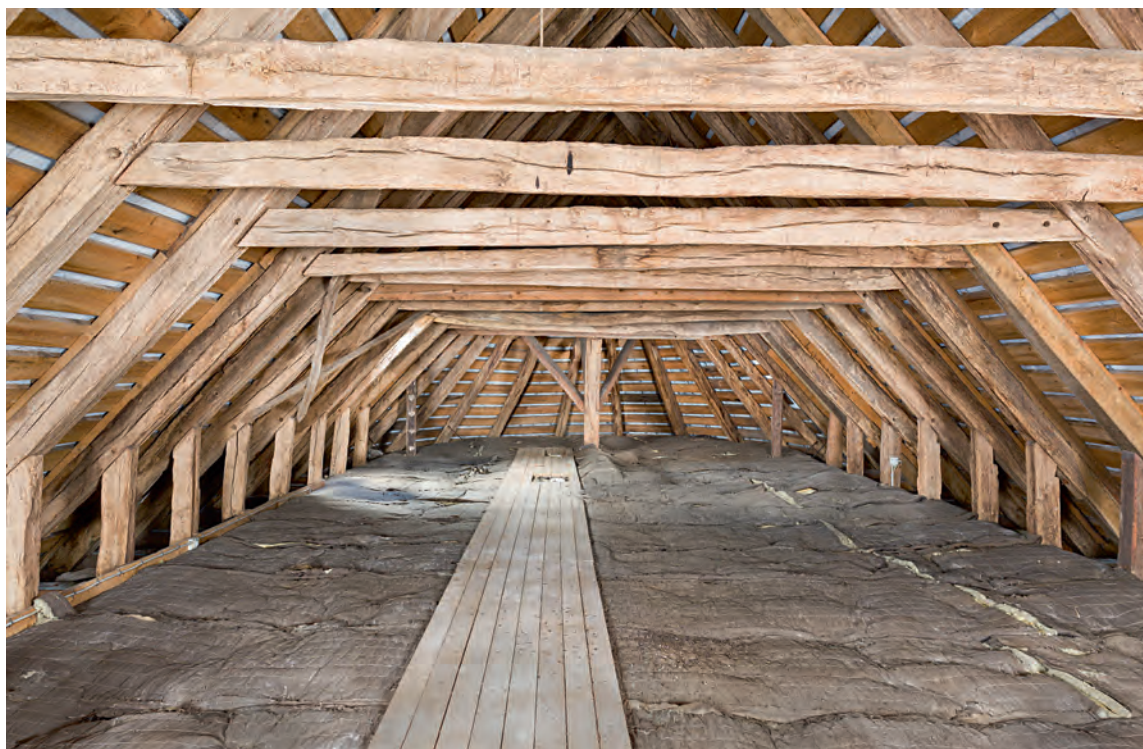
Fig. 23. Skibets loft og tagværker set mod øst (s. 2572). Foto Arnold Mikkelsen 2016. – Loft and roofing of nave looking east.
