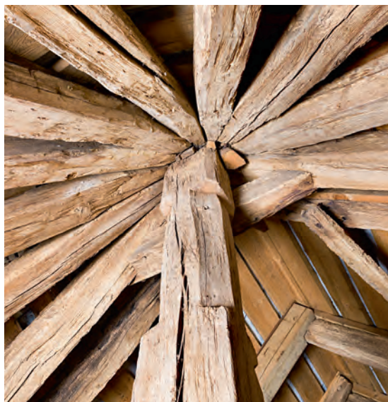
Fig. 24-25. Apsistagværk. 24. Detalje set mod sydvest (s. 2572). 25. (th.) Kongestolpe (o. 1445-50) i apsis-tagværket set mod nordøst (s. 2572). Foto Arnold Mikkelsen 2016. – Apsis roofing. 24. Detail, looking south west. 25. (right) Kingpost (c. 1445-50) in apse roofing looking north east.
