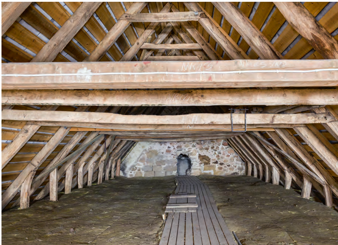
Fig. 19. Skibets tagværk set mod øst (s. 2414). Foto Arnold Mikkelsen 2015. – Roofing of nave looking east.
