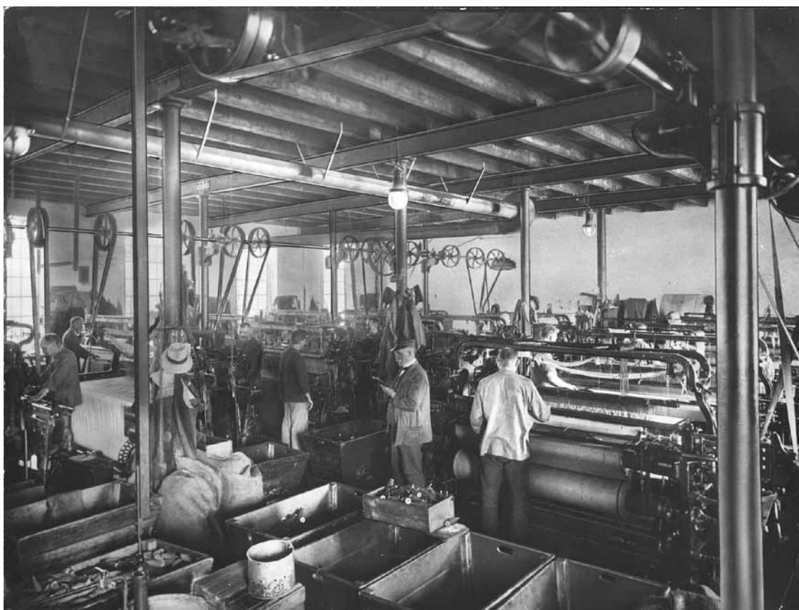
I Danmark slog industrialiseringen først igennem i anden halvdel af 1800-tallet. Her ses væveriet på Brandts Klædefabrik i Odense på et fotografi fra 1919. Et udpræget industrielt tableau: de teknisk raffinerede maskiner drives af dampkraft gennem et transmissionssystem under loftet.
