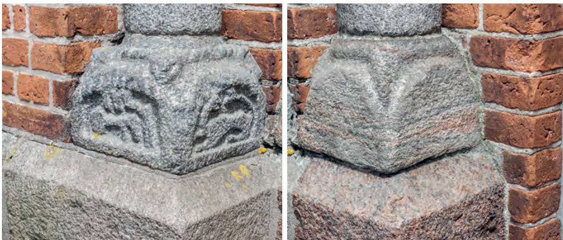
Fig. 14-15. Granitøjleportalens søjlebaser, nord. Foto Arnold Mikkelsen 2022. 14. Ydre søjlebase (s. 3618). 15. Indre søjlebase (s. 3618). – Column bases on portal with granite columns, north. 14. Outer column base. 15. Inner column base.
