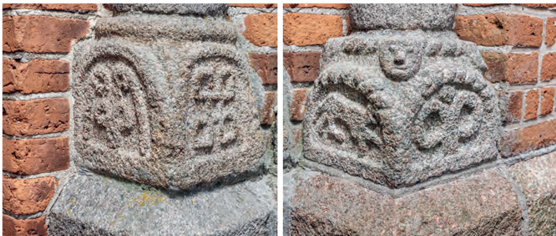
Fig. 18-19. Granitøjleportalens søjlebaser, syd. Foto Arnold Mikkelsen 2022. 18. Indre søjlebase (s. 3618). 19. Ydre søjlebase (s. 3618). – Column bases on portal with granite columns, south. 18. Inner column base. 19. Outer column base.
