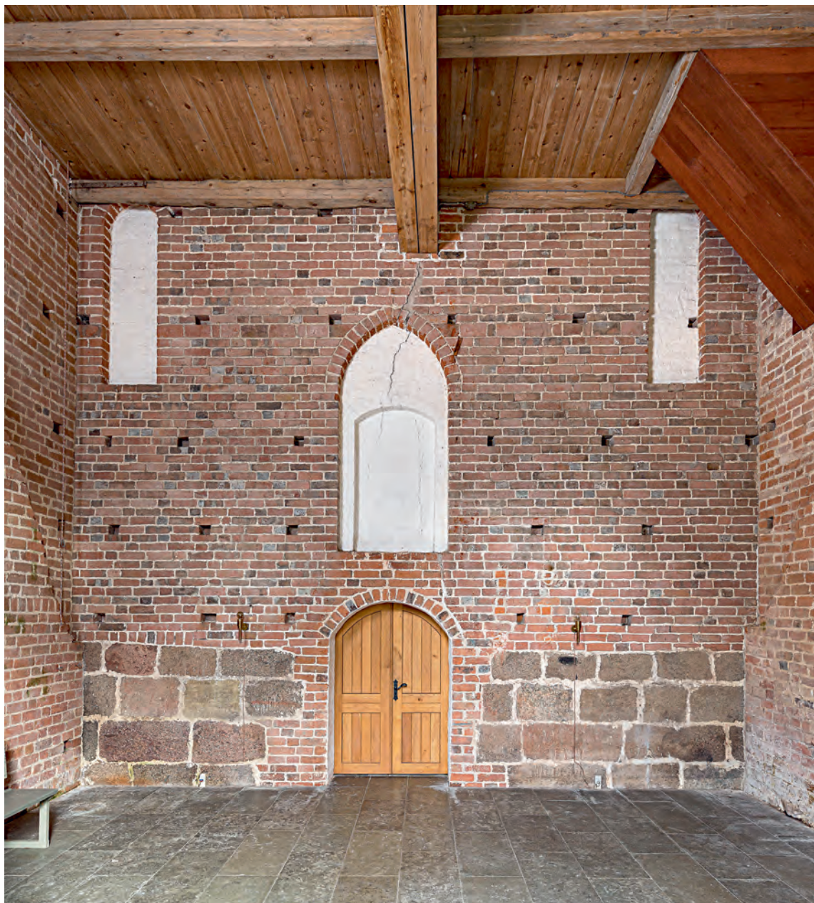
Fig. 17. Tårnrummet set mod øst (s. 5648) med vestforlængelsens oprindelige vestgavl (s. 5643). Foto Arnold Mikelsen 2019. – Interior of the tower with the original west gable of the west extension.
