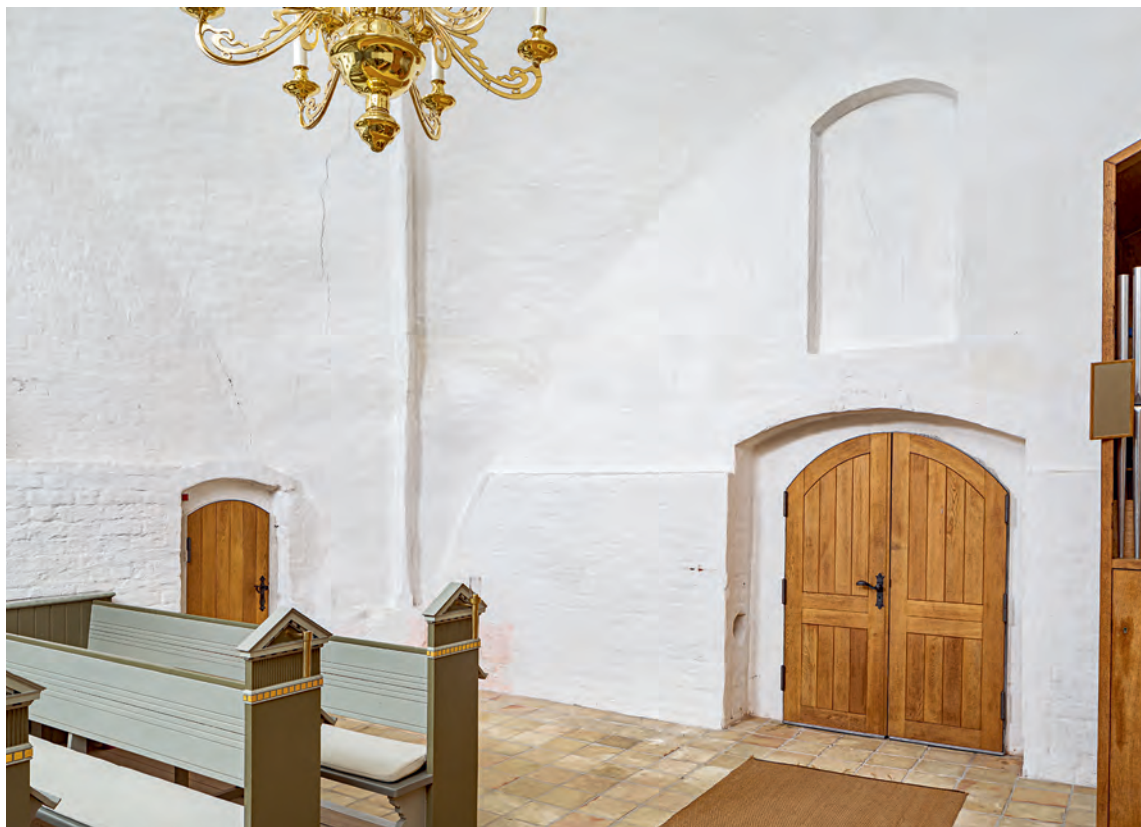
Fig. 19. Indre af skibets vestforlængelse set mod sydvest (s. 5644). Foto Arnold Mikkelsen 2019. – Interior of the west extension of the nave looking south-west.
