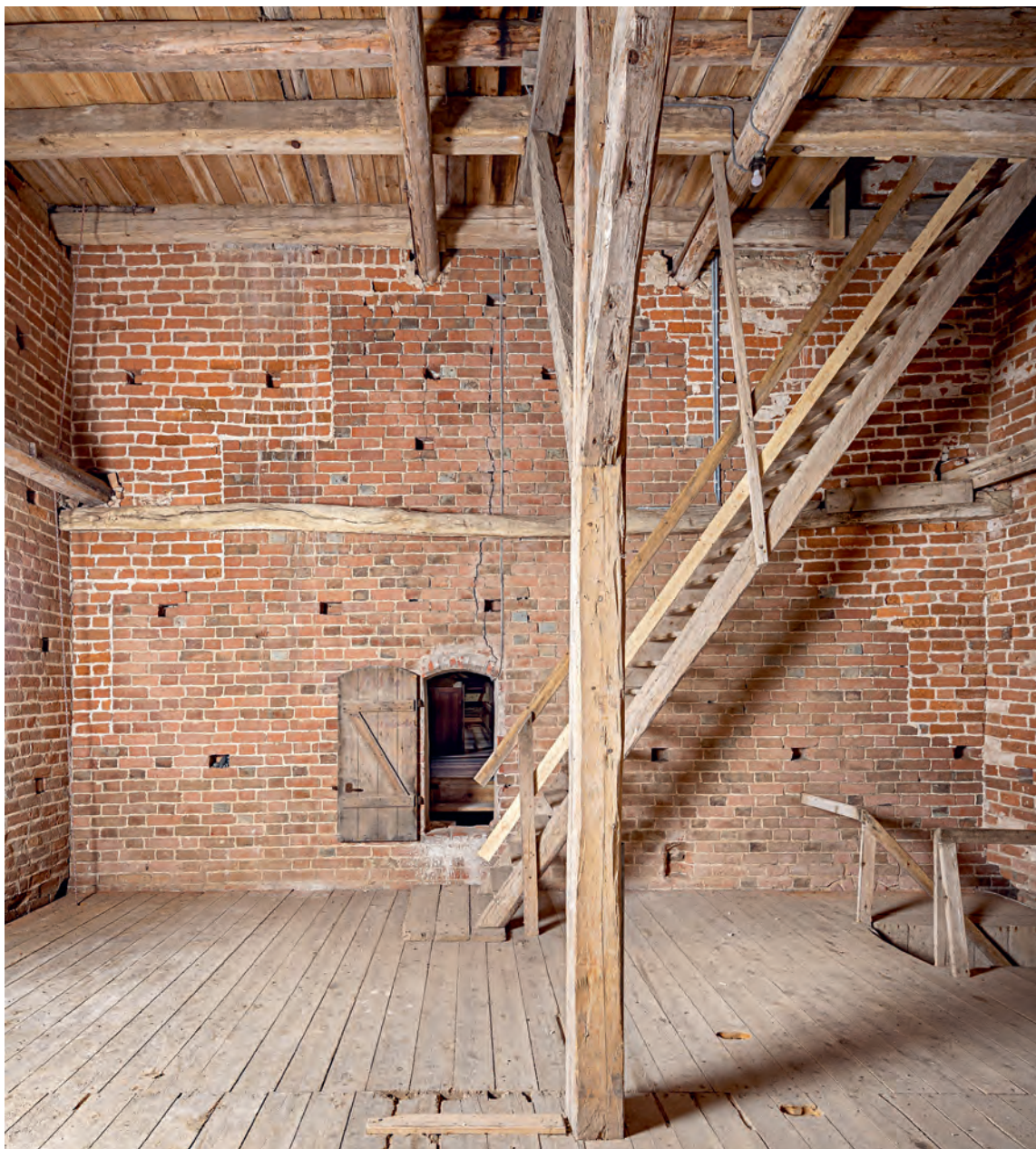
Fig. 18. Tårnets mellemstokværk set mod øst (s. 5652) med vestforlængelsens oprindelige gavltrekan (s. 5646). Foto Arnold Mikkelsen 2020. – Intermediate floor of the tower with the original gable of the west extension.
